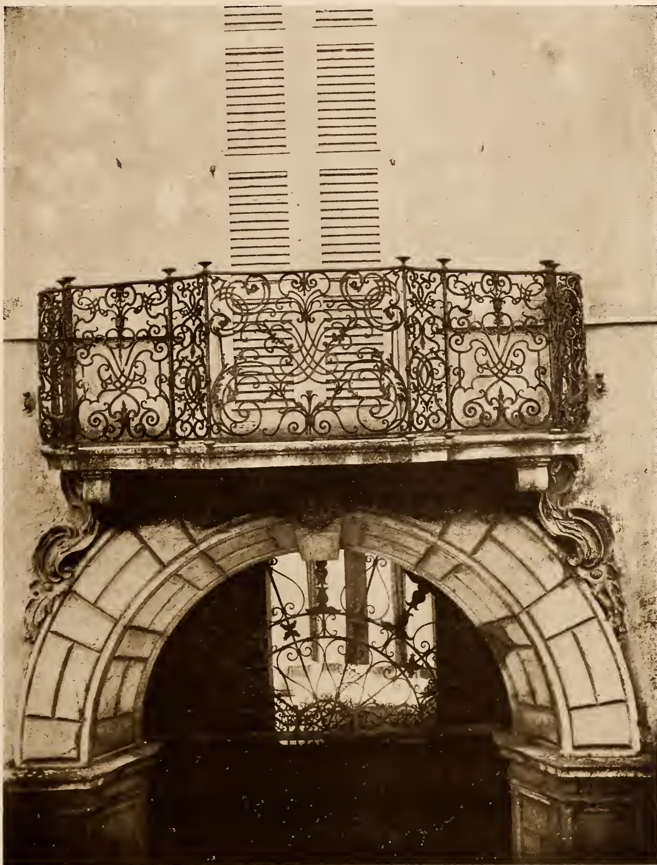
TAV. LVI. — Balcone di Casa Anselmi in Cremona.
