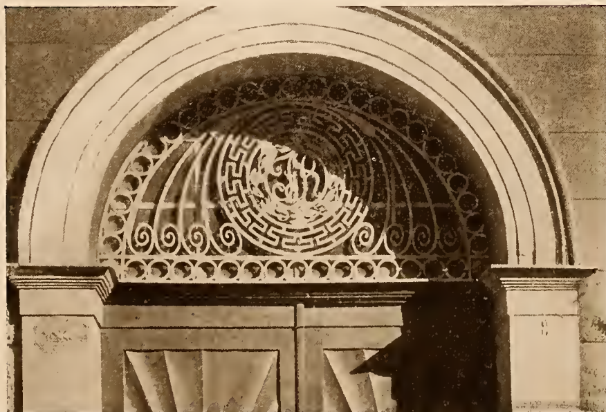
TAV. XI. — Finestra al piano terreno e rosta in due case di Via Ariosto, Reggio Emilia.
